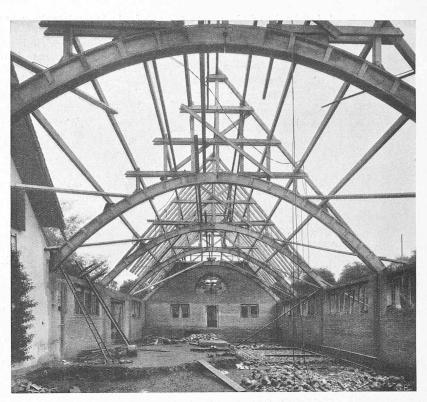
Abb. 3. Dachkonstruktion in Holz nach Bauweise Tuchscherer, von Ing. W. Stäubli, Zürich.
