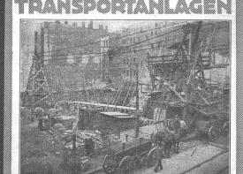
Kabelkran von 50 m Spannweite beim Hausbau Leistung 15 m³/h.
