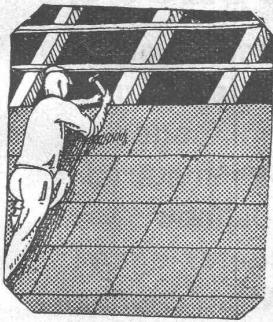
**Diana-Unterdachplatten:** Zweckmässigstes Dachunterkonstruktionsmaterial für Neu- und Umbauten. / Bei bestehenden Bauten können die Dianaplatten ohne Dach- umdeckung leicht und rasch vom Dachinneren aus angebracht werden.
