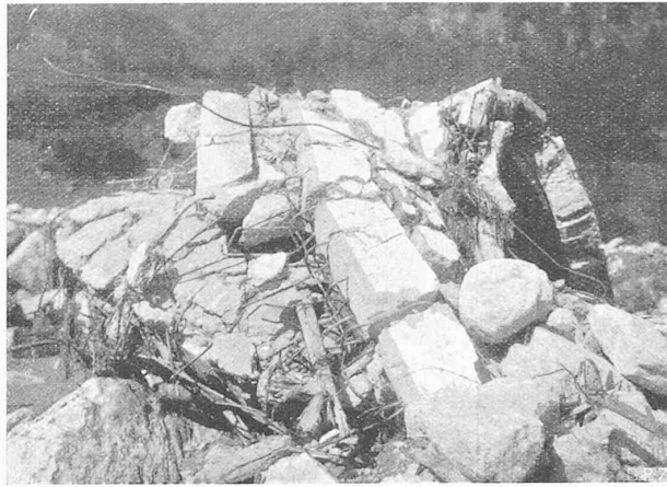
Abb. 5. Die „aufgerollte“ rechtsufrige Brückenhälfte.
