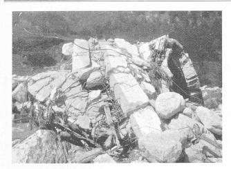
Abb. 5. Die "aufgerollte" rechtsufrige Brückenhälfte.
