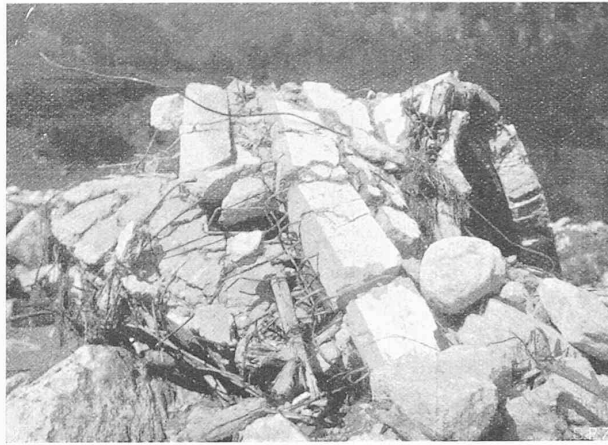
Abb. 5. Die „aufgerollte“ rechtsufrige Brückenhälfte.
