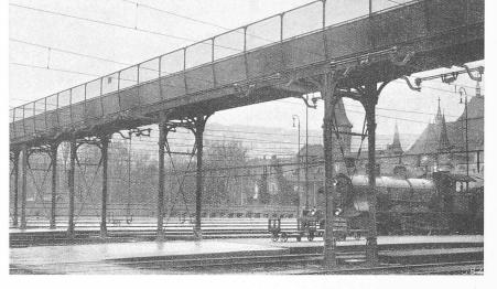
Abb. 12. Durch Gewicht nachgespannte Leitung.
