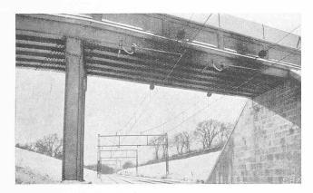
Abb. 10. Abfangen des Tragseils unter Ueberbauten; Fahrdraht frei durchgeführt.
