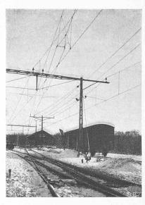
Abb. 11. Fahrdraht-Spreizung über engl. Weichen.
