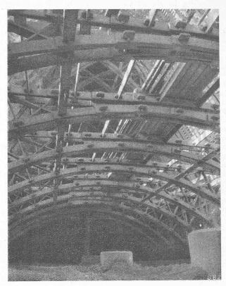
Abb. 8 und 9. Dachstuhl des Mittlelschiffs, links über dem Zugband aufgenommen, rechts darunter (wie in Abb. 4).
