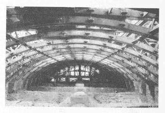
Abb. 4. Dachstuhl des Mittelschiffs, Bogen unter dem Zugband.
