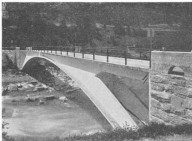
Abb. 14. Strassenbrücke über den Rhein bei Tavanasa, Graubünden. Dreigelenkbogen von 51 m Stützweite, mit kastenförmigem Aufbau, gebildet aus zwei Längswänden mit der darüber gelegten Fahrbahntafel. Entworfen und erbaut 1904/05 durch Maillart & Cie.
