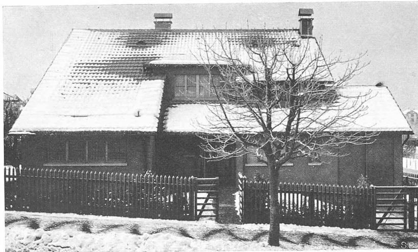
NORDSEITE, MIT EINGANG VON DER KRÄHBÜHLSTRASSE
