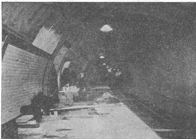
Station South Wimbledon der Londoner Untergrundbahnen, wo starke Wassereinbrüche mit schnellbindender „SIKA“ gedichtet wurden.
