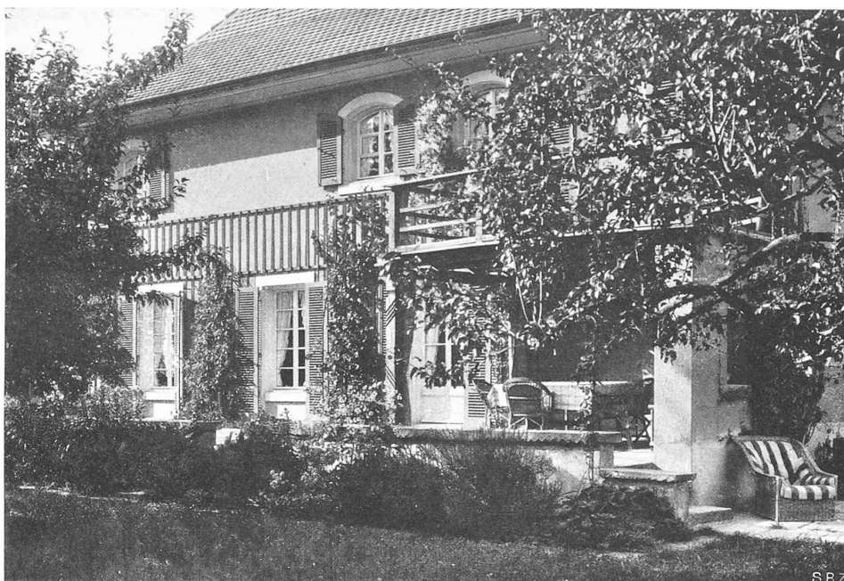
WOHNHAUS DES ARCH. MAX KOPP, AM HOHENRAIN, KILCHBERG ANSICHT DER GARTENFRONT, MIT LAUBE UND TERRASSE UNTEN WOHNSTUBE IM ERDGESCHOSS
