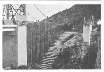
Fig. 5. Pièces transversales attachées aux suspentes et formant l'intrados du cintre.
