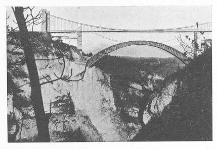
Fig. 2. Le Pont de la Caille au-dessus du torrent des Usses. Au premier plan le pont suspendu actuel, au second plan le cintre du nouveau pont.
