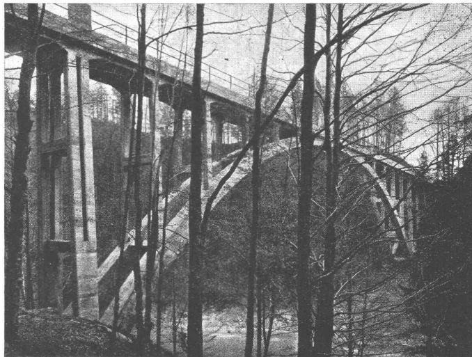
Eisenbetonbrücke über die Sihl bei Schindellegi.
