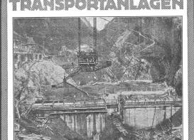
Schwenkbarer Doppel-Kabelkran von 260 m Spannweite mit fahr-barer Beton-Giessvorrichtung beim Bau der Wäggitalsperre.
