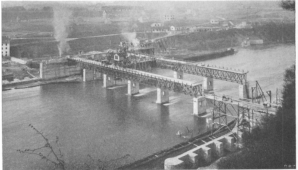
Abb. 14. Provisorische Dienstbrücken für den Bau des Stauwehrs, vom rechten Rheinufer aus gesehen.
