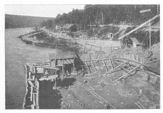
Abb. 15. Baugrube für die Schleuse am rechten Rheinufer.
