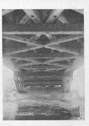
Abb. 6. Untere Windverbände a, b und c.
