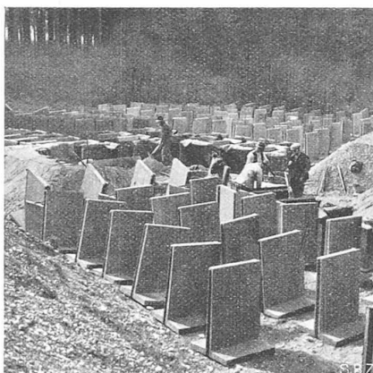
Abb. 9. Betonieren der Betonplatten System Schaub in der Kiesgrube Flaach.
