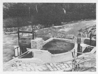
Abb. 22. Grundablass und Einlaufbauwerk.
