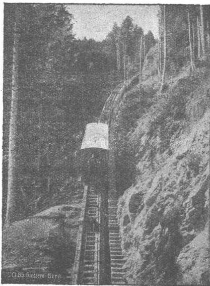
Seilbahn Niesen, I. Sektion, maximale Steigung 66 %.
