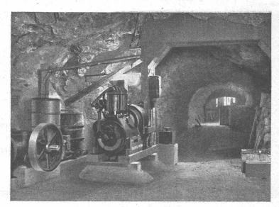
Im Betrieb bei der Jungfraubahn, Station Jungfraujoch, (höchste Eisenbahnstation Europas 3500 m ü.M.) b. Bau des Sphinxstollens zur Spelsung von zwei Höchleistungsbohrhämmern, System Flottmann, Luftverbrauch je 1500 l/min.
