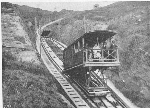
Abb. 3. Wagen mit Personenkabine, an der Ausweiche.
