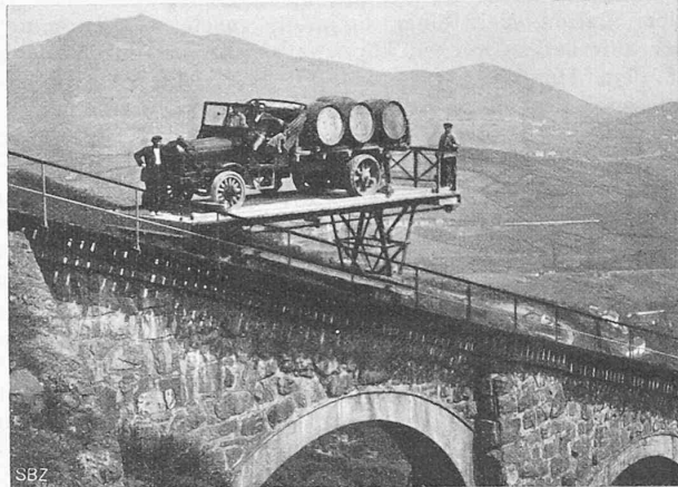
Abb. 2. Wagen mit Plattform für Automobiltransport.
