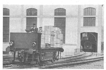
Akkumulatoren - Lokomotive für den Verschiebedienst in den BBC-Werkstätten und auf dem Bahnhof Baden.
