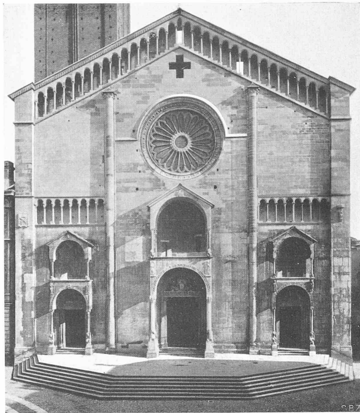
PIACENZA, DOMFASADE, BEGONNEN 1122 OBERE HÄLFTE VON DER ZWERG Gallerie AN MODERN ERNEUERT
