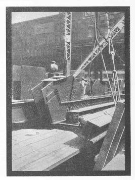
Abb. 11. Diagonalglied des frontalen Gitterträgers über der Frachtplattform.
