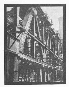
Abb. 12. Gitterträger aus genieteten Gliedern (vergleiche Abb. 11).
