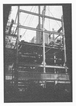
Abb. 13. Detail der Skelett-Konstruktion, Abnehmen der Knotenbleche nach oben.
