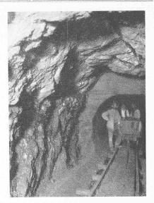
Abb. 21. Kontaktzone: unten weicher Mergel, oben klüftiger Dolomit.
