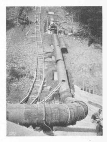
Abb. 27. Die Druckrohrleitung im Bau.
