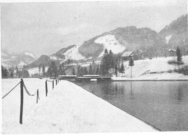
Abb. 8. Linkes Ufer der Stauhaltung, gegen das Wehr.
