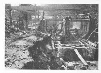
Abb. 14. Entsandungsanlage System Dufour, im Bau.
