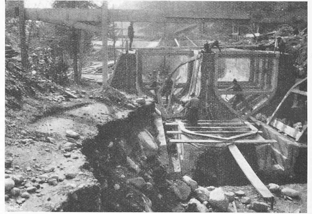
Abb. 14. Entsandsanlage System Dufour, im Bau.
