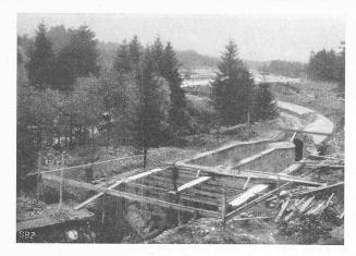
Abb. 13. Entsandungsanlage im Bau; im Hintergrund Wehrstelle.
