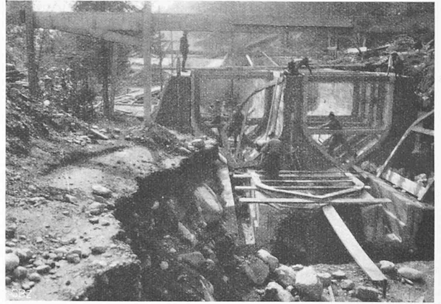
Abb. 14. Entsandsanlage System Dufour, im Bau.
