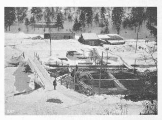
Abb. 6. Rechtsufriger Senkrahmen in Absenkung. im Hintergrund der versenkte erste Rahmen.
