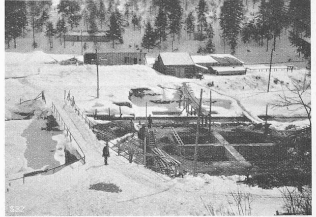
Abb. 6. Rechtsufriger Senkrahmen in Absenkung, im Hintergrund der versenkte erste Rahmen.
