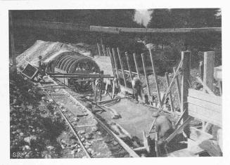
Abb. 15. Ausführung des gewölbten Kanals im Tagbau.
