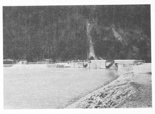
Abb. 9. Rechtes Ufer der Stauhaltung, Wehr und Fassung.
