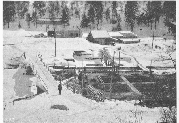
Abb. 6. Rechtsufriger Senkrahmen in Absenkung. im Hintergrund der versenkte erste Rahmen.
