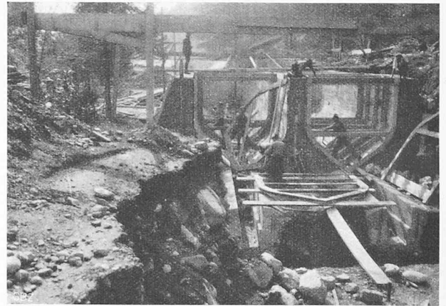
Abb. 14. Entsandungsanlage System Dufour, im Bau.
