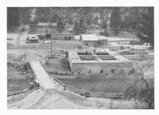
Abb. 5. Linksufriger Senkrahmen des Wehres bei Radin, vor der Absenkung. Links der alte Steg.
