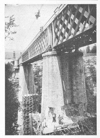
Abb. 6. Hauptpfeiler Seite Lausanne mit den Ausbrüchen für die Einmauerung der Gewölbe-Kämpfer der kleinern Seitenöffnung.
