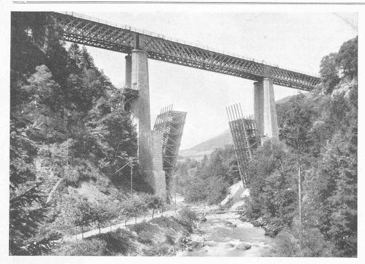
Abb. 5. Erstellung des Lehrgerüstes für den mittlern Bogen. Ansicht flussaufwärts.
