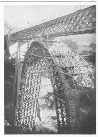
Abb. 7. Mauerung in der Bogenhälfte Seite Vallorbe der Mittelöffnung.
