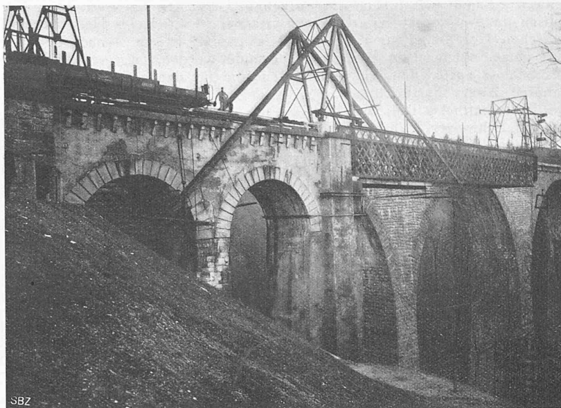
Abb. 3. Abbruch des letzten, rechtsufrigen Ueberbaues; Verankerung im Mauerwerk des Viadukts.
