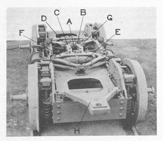
Abb. 2. Laufräder-Drehgestell der Lokomotive der Paris-Orléans-Bahn.
