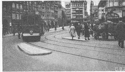
Abb. 13 bis 15. Amsterdam, am Konings-Platz: Nach Süden spitz zulaufende, schlank gebogene, den Verkehrsströmen entsprechend gegeneinander versetzte Perroninseln; westlich (rechts) ein kleines Dreieck. Links gegen SW, Mitte gegen SO, rechts gegen NO.
