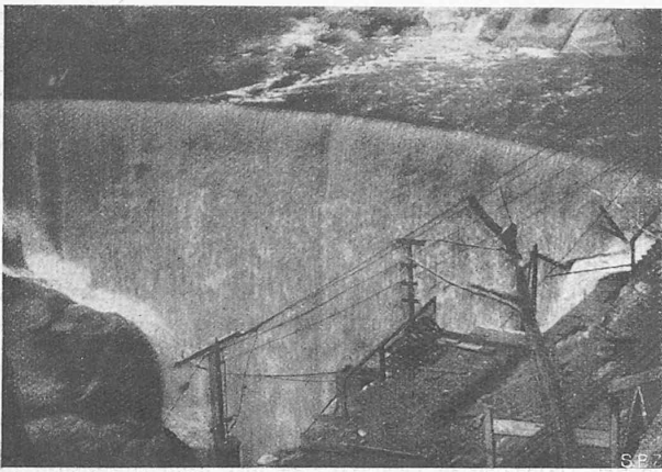
Die Versuchs-Gewölbe-Staumauer am Stevenson-Creek in Kalifornien während des Hochwassers vom 27. November 1926.
