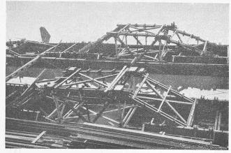
Abb. 4. Die Abfangegerüste, links die geknickten Streben.
