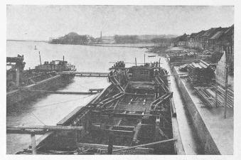
Abb. 5. Ausgeknickte Schrägstreben des einen Abfangegerüstes.
