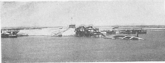
Abb. 6. Rechtsufriger Ueberbau nach 140 Sprengschüssen.
