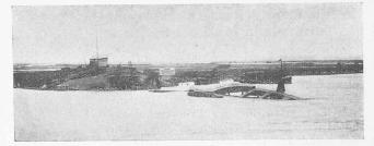
Abb. 6. Rechtsufriger Ueberbau nach 140 Sprengschüssen.
