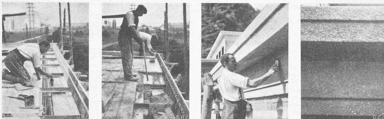
Abb. 1 bis 4. Behandlung der Betonsichtflächen nach dem Context-Verfahren am Gesimse der Zentrale des S. B. B.-Kraftwerks Vernayaz.
