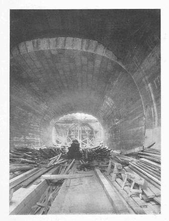
Abb. 6. Sihltunnel (rechtsufrige H\u00e4lfte), gegen Wiedikon gesehen. Granit-Gew\u00f6lbestirne des reduzierten Unterfahrungs-Profils.
