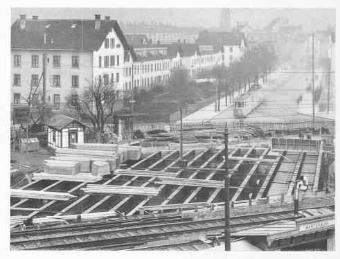
Abb. 34. Brücke für die Badenerstrasse, Draufsicht während der Montage.
