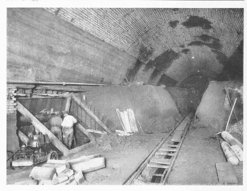
Abb. 11. Abbau der Strosse, Ausschachtung für Widerlager und Gewölbe-Unterfangung (Ulmberg).
