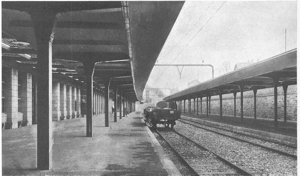
Abb. 23. Bahnsteigdächer des Bahnhofs Enge, gegen Süden gesehen.
