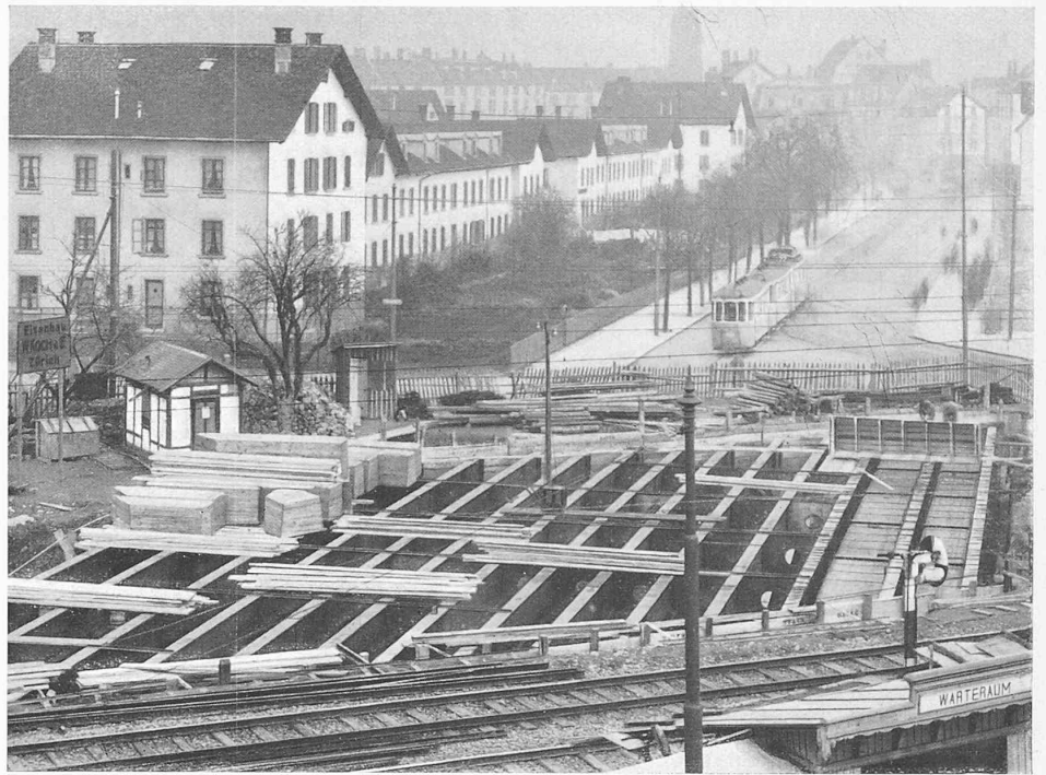
Abb. 34. Brücke für die Badenerstrasse, Draufsicht während der Montage.
