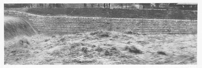
Abb. 5. Ansicht des Sihlüberfalls am 4. November 1921 bei H.-W. von 215 m³/sek, gleich ²/5 des zu gewärtigenden Katastrophen-Hochwassers.
