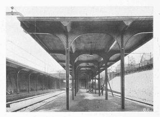
Abb. 31. Eisen- und Eisenbeton-Bahnsteigdächer.
