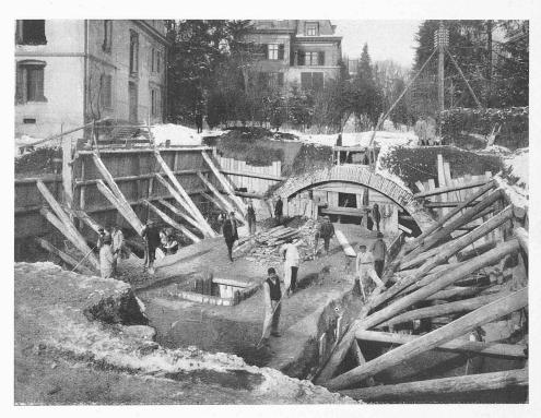
Abb. 9. Tagbau am Südende des Ulmberg-Tunnels (anschliessend am bergmännischen Teil, vergl. Abb. 8).
