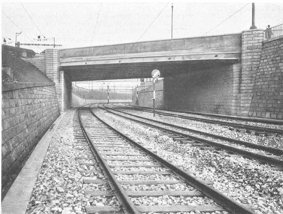
Abb. 35. Ueberführung der Badenerstrasse über vier Geleise, Stützlänge der Walzträger 27,5 m.
