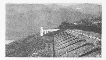
Abb. 3. Wasserseite und Krone des wiederhergestellten Staudamms.
