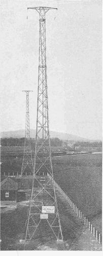
Abb. 3. Antennentürme, 40 m hoch.
