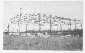
Abb. 1. Fertig montierte Eisenkonstruktion der Halle,
