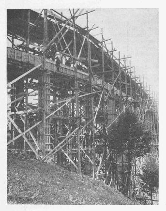
Abb. 6. Anschlussviadukt-Einschalung, darüber die Dienstbrücke.
