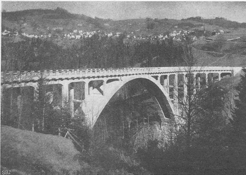
Abb. 8. Ansicht der fertigen Rotbachbrücke aus Südwest, gegen Teufen.
