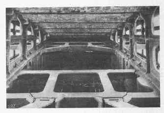
Abb. 4. Beschädigter gusseiserner Längsverband.
