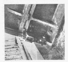
Abb. 8. Verbindung der Verstärkungs-Rundeisen mit den Auflagerschuhen.
