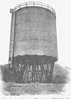
Genieteter Laugenbehälter von 1000 m³ bezw. 1350 Tonnen Inhalt, 10,8 m Durchmesser, 12 m Höhe, mit Spezialbodenkonstruktion.
