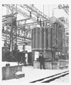
Abb. 9. Transformatoren und zugehörige 60 kV-Schalter.
