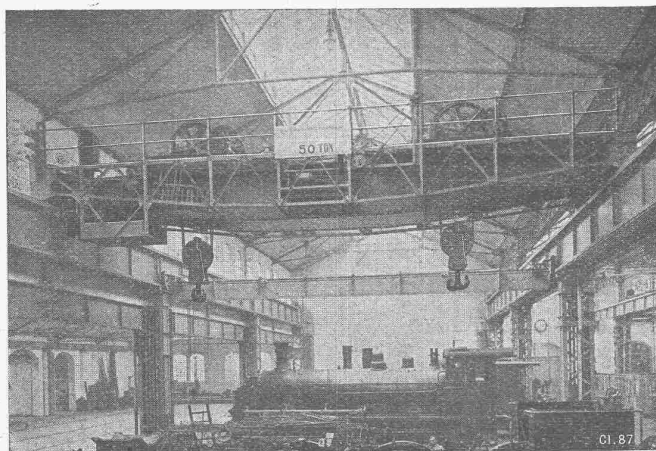
Lokomotivhebekran von 50 Tonnen Tragkraft, in den Reparaturwerkstätten der S. B. B. in Zürich.
