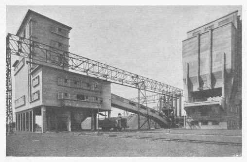
Abb. 13. Koksseparation der Gewerkschaft "Sachsen" in Hamm (Gebäudehöhe 28,3 m). — Rechts Feinkohlensilo.
