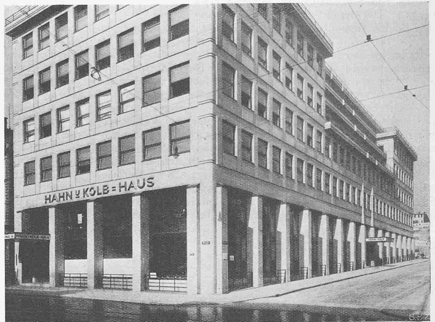
Abb. 12. Geschäftshaus in Stuttgart, unverputzter Eisenbeton-Skelettbau.
