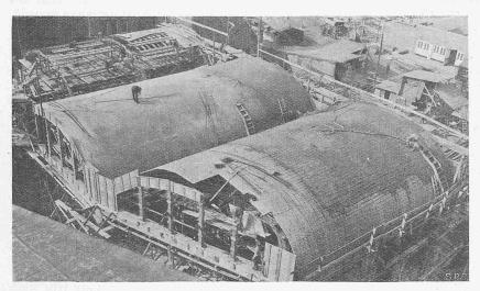
Abb. 11. Schalengewölbe System Zeiss-Dyckerhoff & Widmann, 5,5 cm stark ("Gesolei" 1926).
