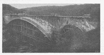
Abb. 5. Die Wahnbachbrücke während der Betonierung.
