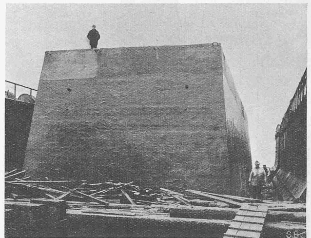
Abb. 9. Eisenbeton-Senkkasten für die Oderbrücke Stettin.
