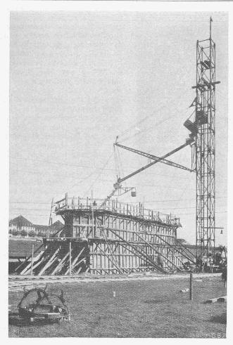
Abb. 8. Giessen eines Eisenbeton-Senkkastens für die Pfeilergründung der Friedr. Ebertbrücke in Mannheim.
