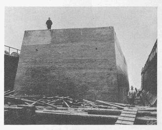
Abb. 9. Eisenbeton-Senkkasten für die Oderbrücke Stettin.
