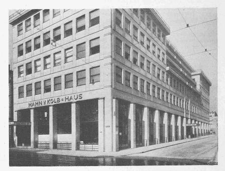
Abb. 12. Geschäftshaus in Stuttgart, unverputzter Eisenbeton-Skelettbau.
