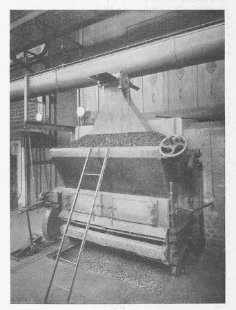
Abb. 6. Kessel mit automatischer Beschickung und Wanderrost.
