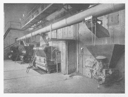
Abb. 5. Blick in das Kesselhaus mit den vier automatisch beschickten Kesseln.
