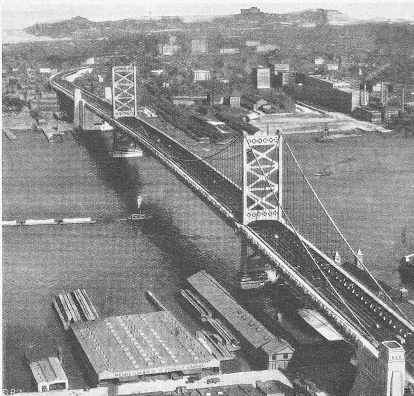
Abb. 1. Die neue Hängebrücke über den Delaware River in Philadelphia; Mittelöffnung 534 m weit.
