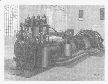
Gleichstrom-Anzapf-Turboaggregat, 2500 kW Leistung, Drehzahl 3000/750, 12 kg/cm² Ueberdruck, 300°C mit Zahnradvorgelege.
