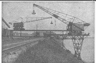
Hochbahn-Drehkran für Greiferbetrieb. Halbportal-Drehkran für Greifer- und Tragkraft 4 t, Ausladung 26 m, Hochbahn 200 m lang.
