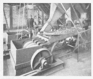
Abb. 2. Elektromagnetischer Aschenscheider, System Ullrich.
