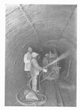
Stollenauskleidung mit schnellbindender Sika mittels Zementkanone, in Oesterreich
